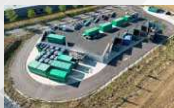
Déchèterie de Vendeuvre-sur-Barse
