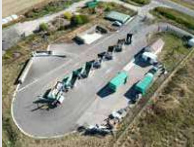
Déchèterie de Brienne-le-Château
