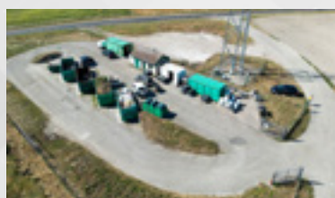
Déchèterie de Piney
