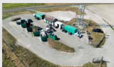
Déchèterie de Piney
